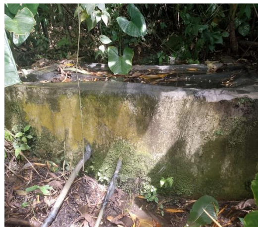
Imagen 4. Tanque desarenador
