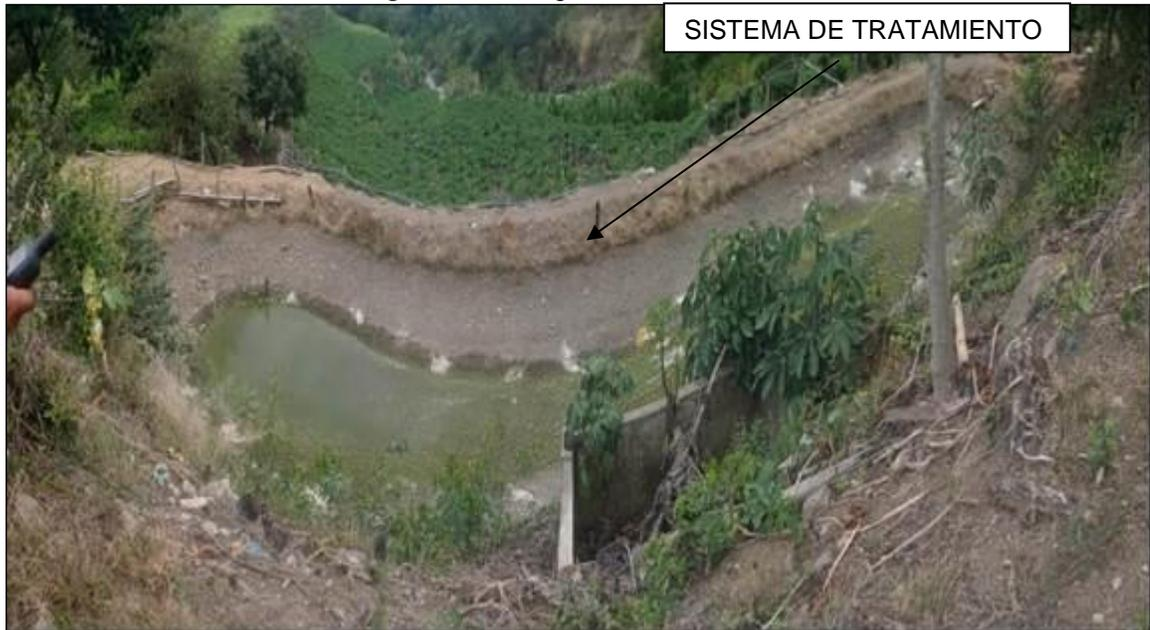
**Fotografía N°10: Punto de Descarga del monitoreo se conduce en tubería PVC de 4" de la laguna de oxidación a la Quebrada la Chonta.**
