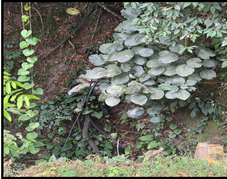
Imagen 5 – Descarga del vertimiento de las ARD y ARnD a la alcantarilla
