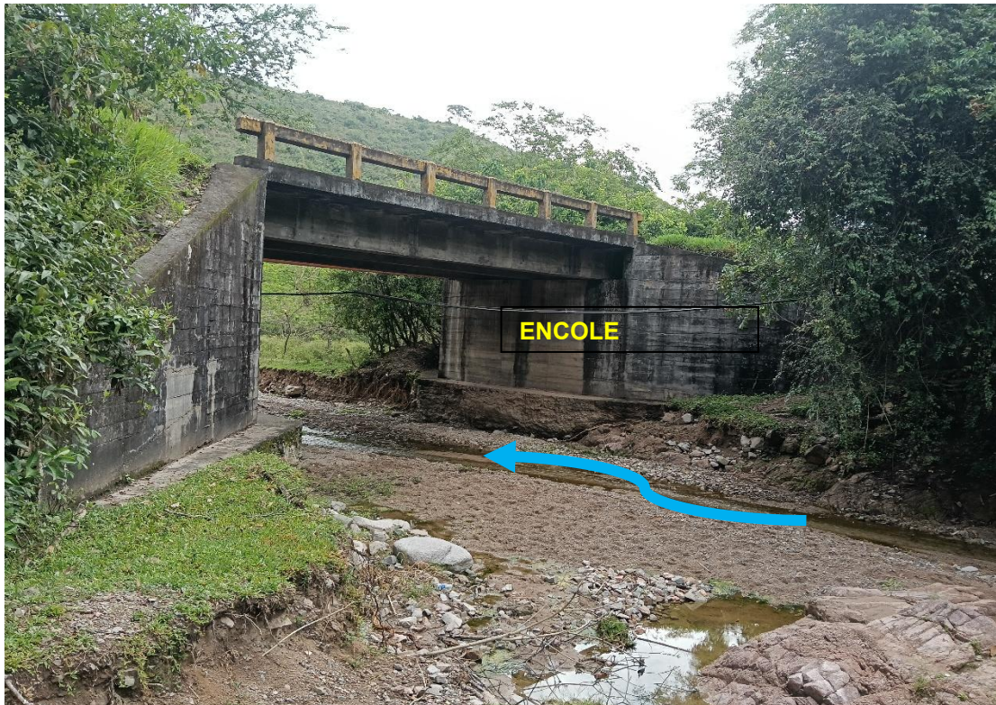
Fotografía 1, 2 y 3. Panorámica sitio de intervención sobre La quebrada seca (Encole).
