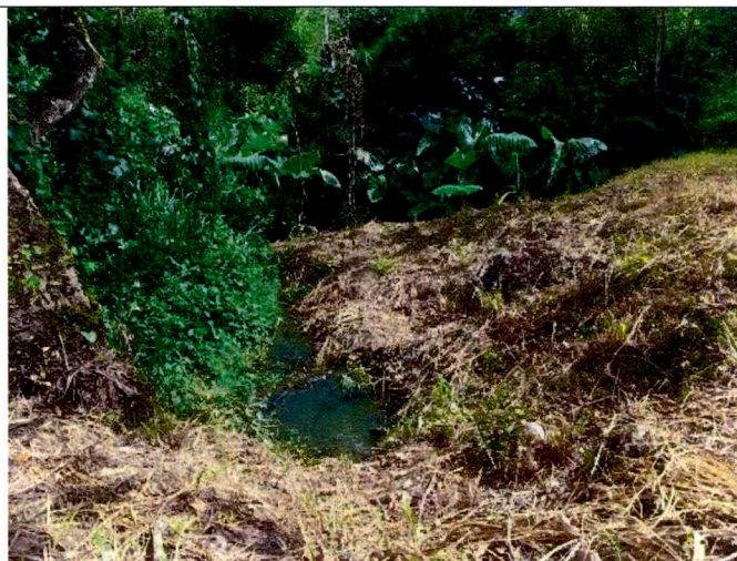
Fotografía 10. Punto de vertimiento después de la laguna de oxidación al canal
