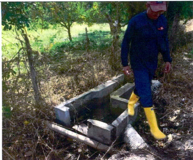
Fotografía 7. Obra de captación
