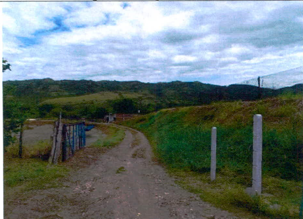
Fotografía 5. Entrada al predio
