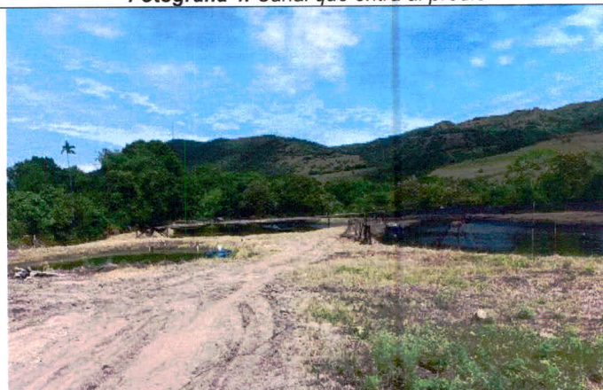
Fotografía 6. Vista panorámica de una de las unidades de producción acuícola
