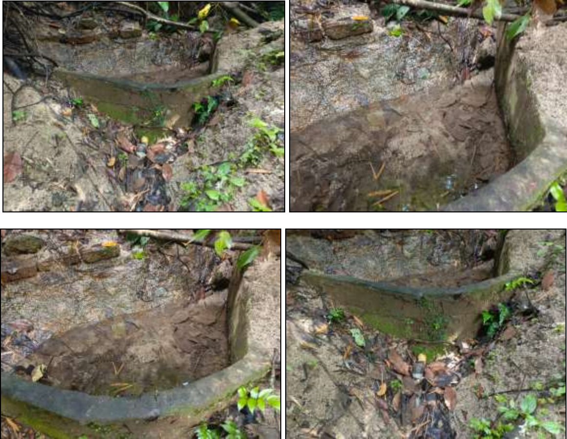
Panorámica de la fuente hídrica y del punto de captación
