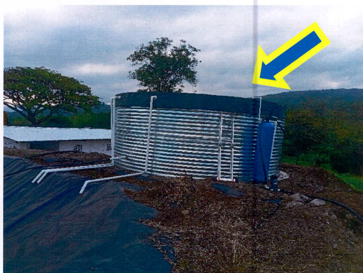
Fotografías N° 3 y 4 -Tanque dosificador coagulante – Tanque australiano
