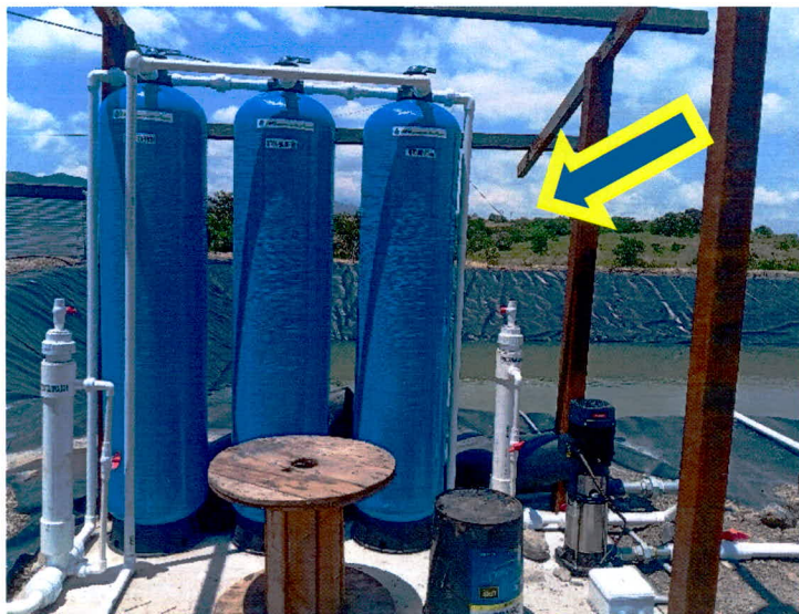
Fotografías N° 6 y 7 Filtros de tratamiento – Tanque de almacenamiento y distribución
