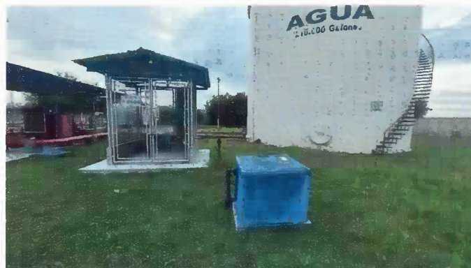
Registro fotográfico 1. Vista del pozo profundo (caja azul)
