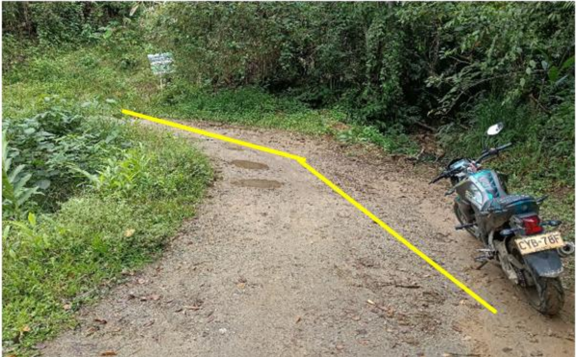
Fotografía 4. Panorámica sitio por donde se instaló el tubo de polietileno del gas natural para el sector el curibano, de la Vereda Bajo Sylvania
