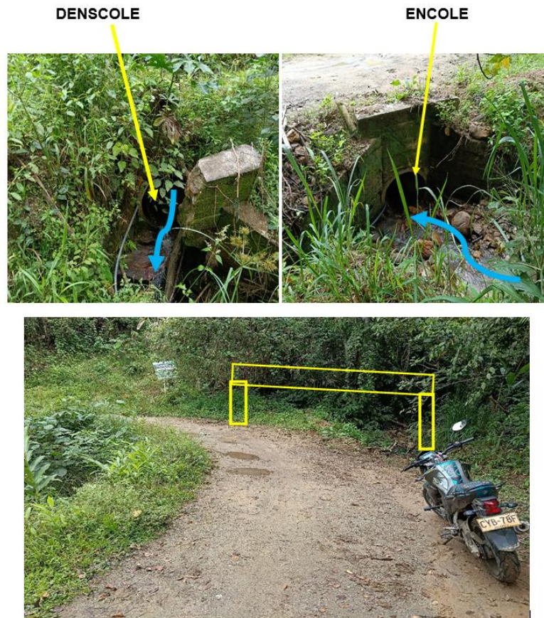
Fotografía 1, 2 y 3. Panorámica sitio de intervención proyectada sobre drenaje natural sin denominación.
