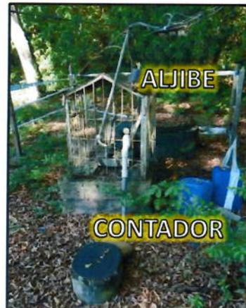
**Registro fotográfico 1:** Antiguas instalaciones del aljibe. En la imagen se tiene como referencia la ubicación del contador, se observa, que, hasta el mes de mayo, el aljibe contaba con instalación de motobomba, tubería y conexión eléctrica. Fuente: CAM 31 de mayo de 2023.
