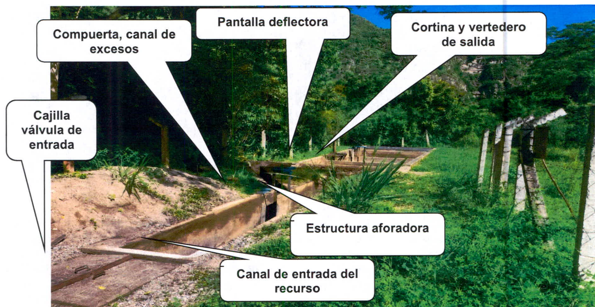
Fotografías 7: Panorámica del desarenador - vereda Cascajal – Gigante - Huila
