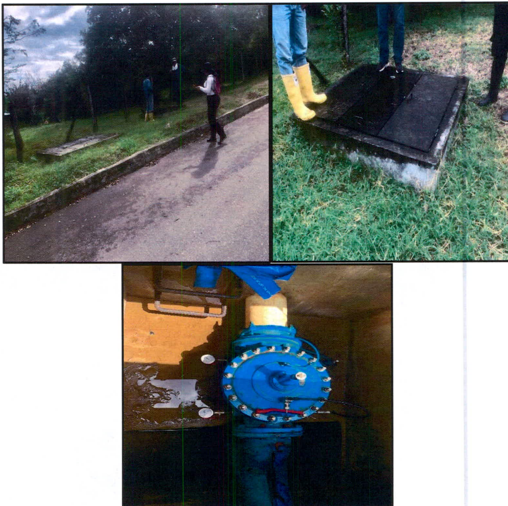
Fotografías 13, 14 y 15: Obra hidráulica Válvula reguladora - vereda Rio Loro – Gigante - Huila
