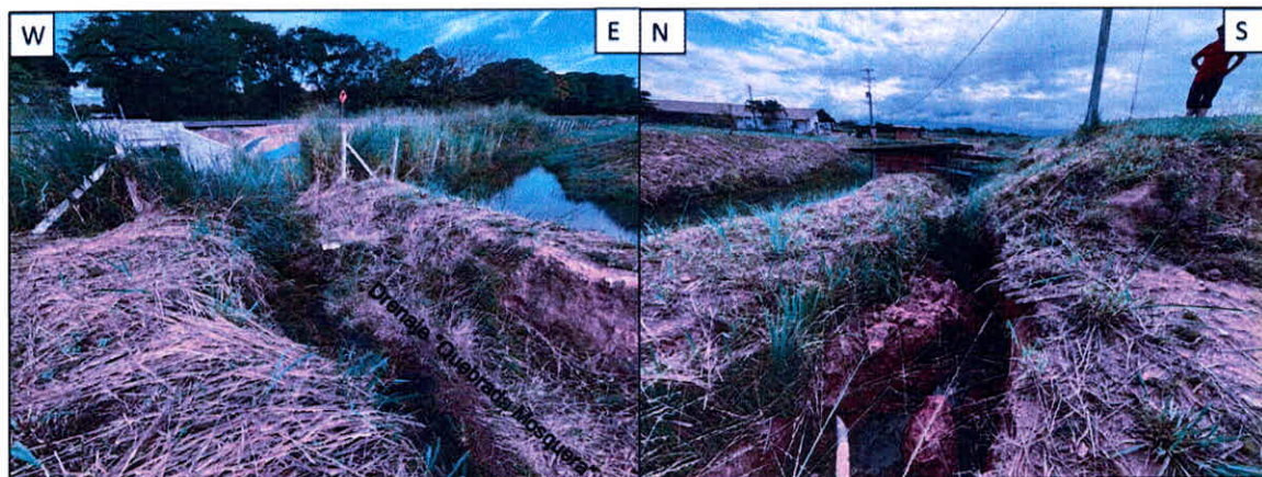
Registro fotográfico No. 1. Vista del punto No. 1, en la cual se identifica el trazado del drenaje proveniente del predio “El Paraíso”, el box culvert localizado en la vía Neiva–Rivera, el lago de recirculación y el punto de descarga correspondiente. Fuente: Propia.
