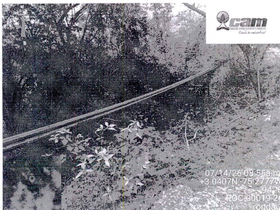
Foto 2 . Punto donde se va a intervenir para las líneas de flujo aerea.
