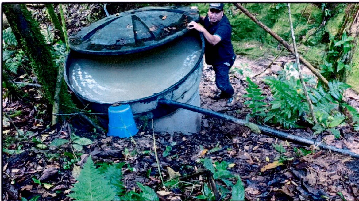
Fotografía No. 4: Tanque desarenador artesanal en material de plástico.
