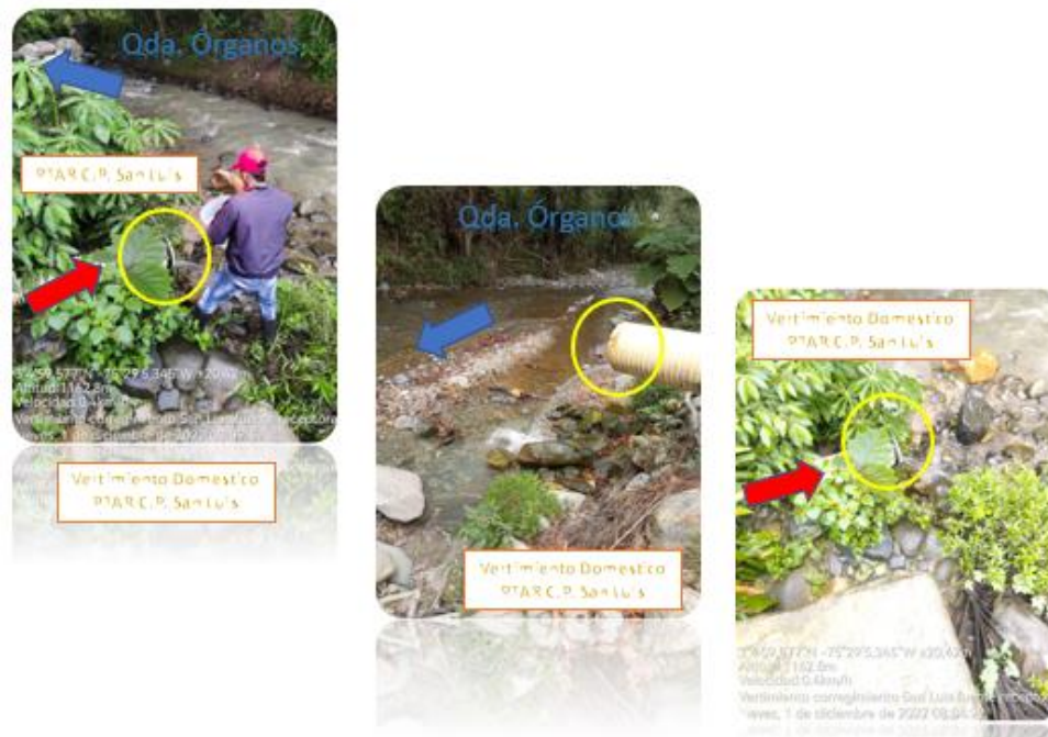
Imagen 14. Inadecuada disposición de residuos líquidos de la PTAR del C.P. SAN LUIS sobre la subcuenca del Rio Aipe en el tramo 02.
