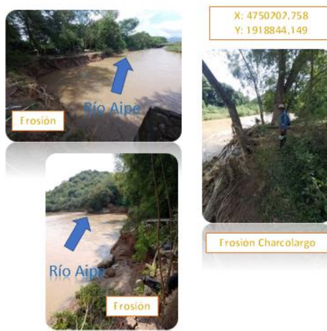
Imagen 22. Procesos erosivos sobre el cauce principal del Rio Aipe sobre el tramo 04 – Charcolargo.
