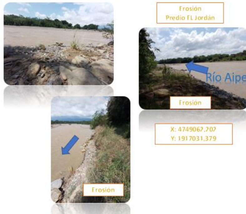
Imagen 20. Procesos erosivos sobre el cauce principal del Rio Aipe sobre el tramo 04 – Predio El Jordán. Fuente: CONSORCIO PORH HUILA, 2022.
