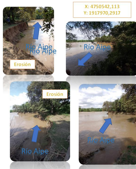
Imagen 21. Procesos erosivos sobre el cauce principal del Rio Aipe sobre el tramo 04.
