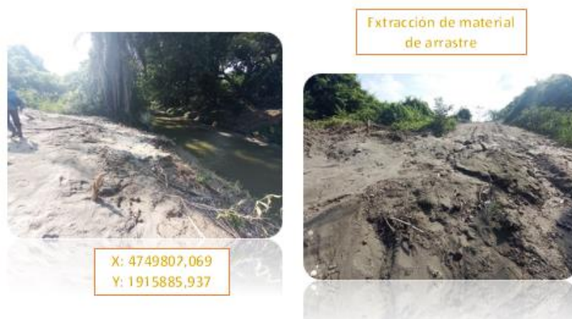
Imagen 24. Extracción de Material de arrastre sobre el cauce principal del Rio Aipe sobre el tramo 04.
