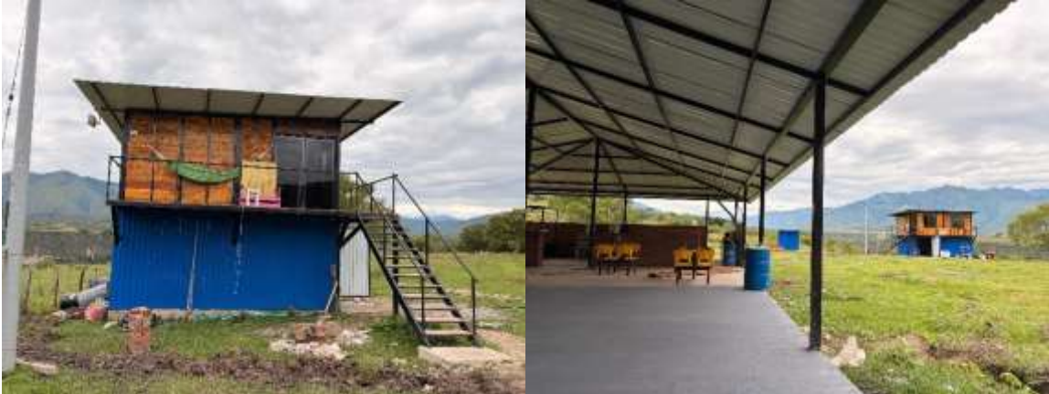
Figuras 2 y 3 Vista general del predio LT 3.
