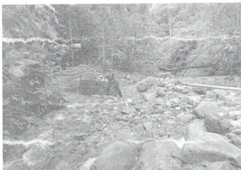
Foto No. 2: lugar y/o sitio donde se construirá la bocatoma de fondo.
