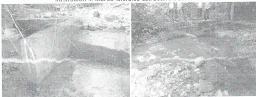
Ilustración 4: Muros laterales estructura bocatoma
