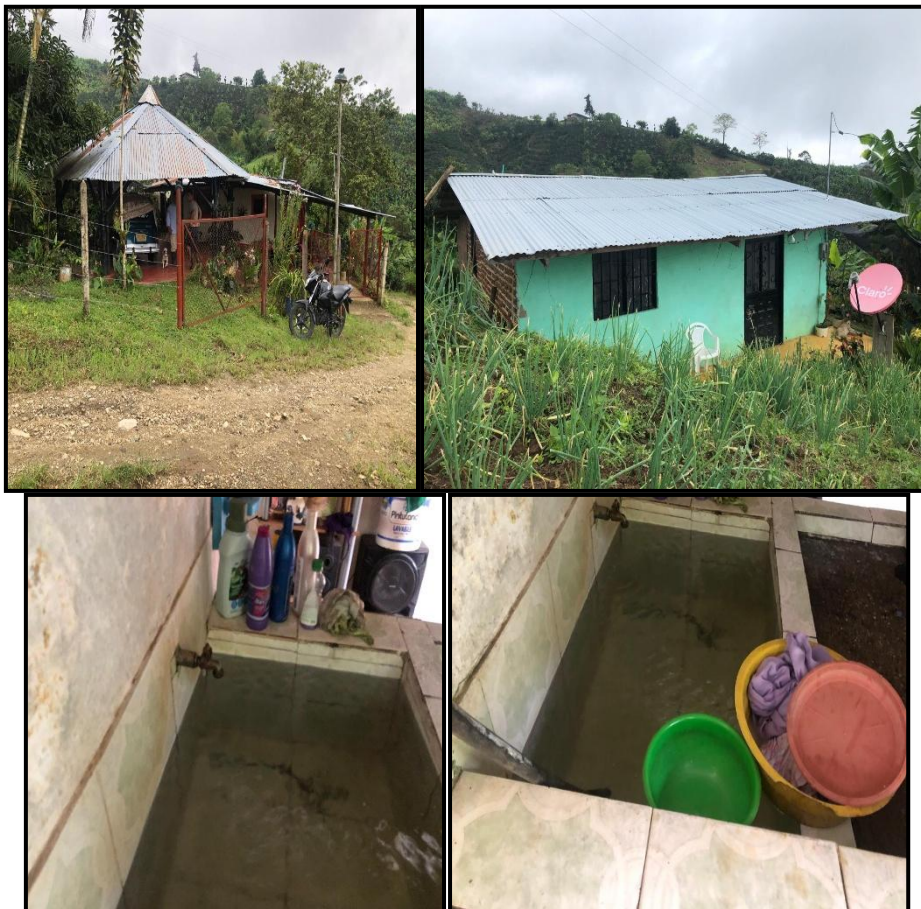
Fotografía 7, 8, 9 y 10. Tanques almacenamiento del recurso y elementos de control del mismo para uso doméstica en la vivienda dentro del predio rural denominado “El Mirador” .
