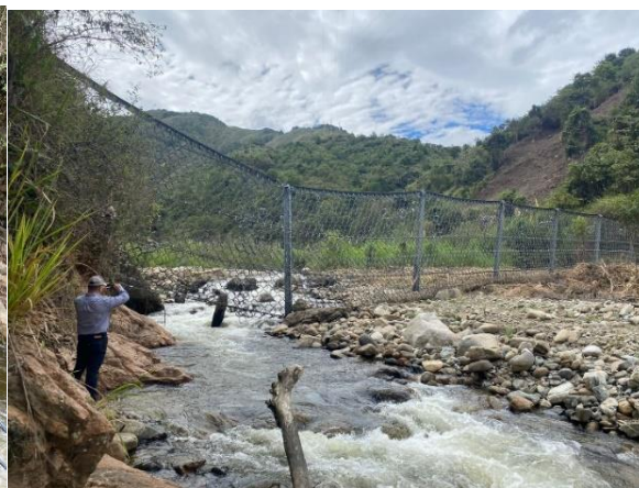
Limpieza, retiro y disposición de residuos sólidos tipo palizada 100 metros aguas arriba y los retenidos en la malla dinámica Km 18+00 y Km 38+00 (Neiva-Balsillas) respectivamente
