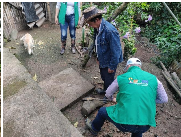
Seguimiento sistema séptico vereda Santa Helena Beneficiario Eduardo Polanía Cerquera
