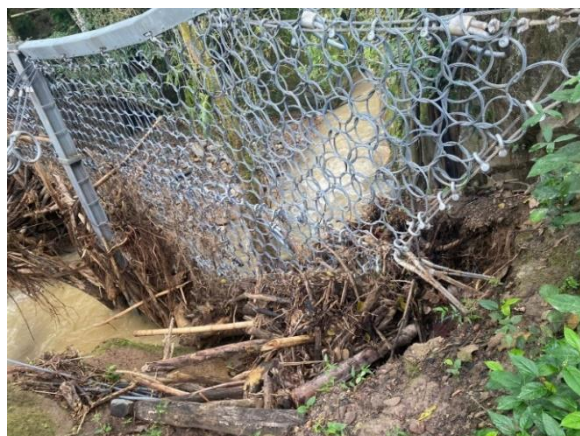
Barrera dinámica reteniendo detritos sobre el cauce de la quebrada Los Micos. Sitio: Km 016+00 vía Neiva-Vegalarga.
