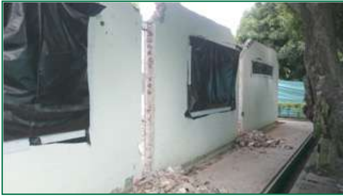
Avance Reforzamiento Estructural – Bloque 4.
