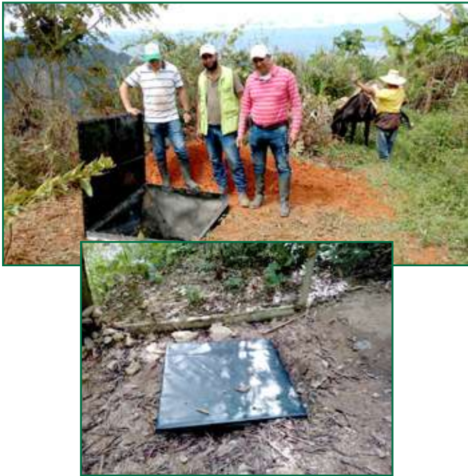
Relleno sanitario en predio de Lucila Méndez, vereda Santa Helena
