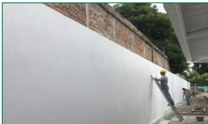
Levantamiento de muro y cerramiento – sede principal
