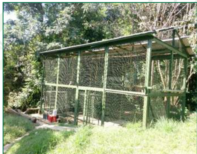
Reconstrucción de jaulas - CAV
