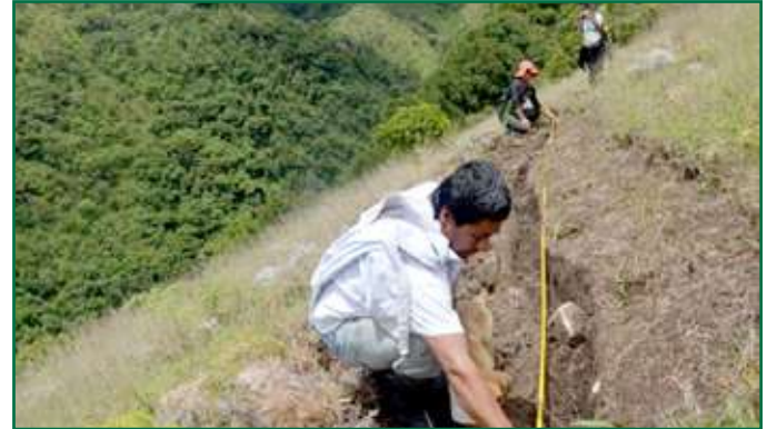
Siembra de roble, predio El Huerto, Vereda San Bartolo, Neiva y Construcción zanjas de infiltración, predio la Bastilla, vereda La Plata, Neiva
