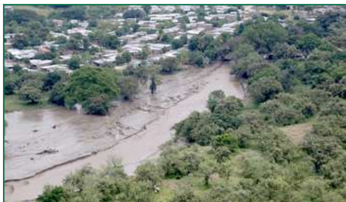
Daños viviendas, zona urbana
