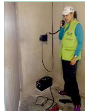
Instalación de radios base en vereda Primavera.
