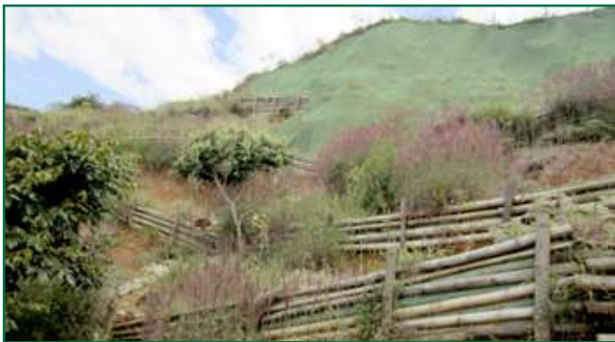
Obras de bioingeniería en proceso erosivo Ginebra (Vereda Primavera), Diciembre 2017
