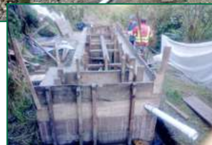
Estado de las obras de construcción de la Bocatoma con desarenador, diciembre de 2017
