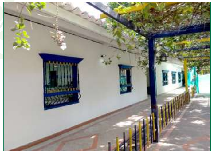
Reforzamiento Estructural – Bloque 2.
