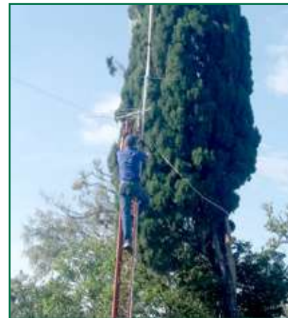
Instalación de radios base en vereda Chapuro.
