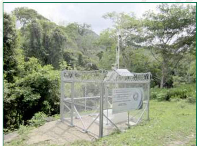
Estación Hidrológica La Lindosa, río Las Ceibas Km 18.
