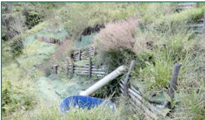
Obras de bioingeniería en proceso erosivo y de remoción Miraflores (Vereda Palestina), Diciembre 2017
