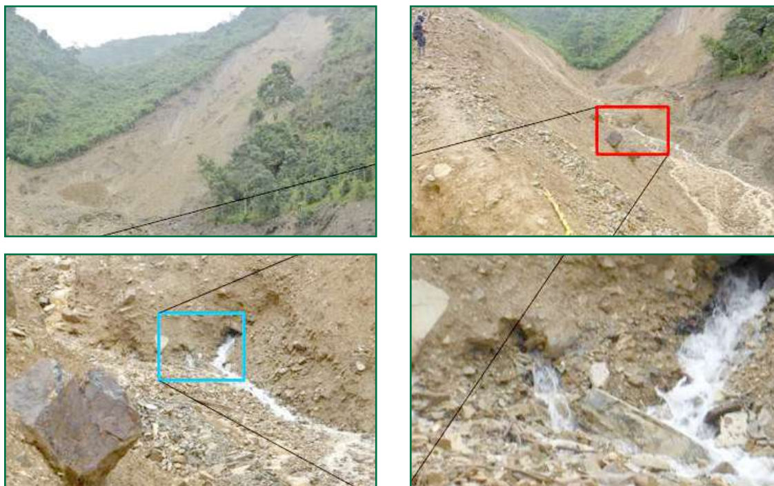
Secuencia fotográfica que destaca la presencia de flujos de agua en la base del material caído sobre un afluente del río Pedernal, vereda Corrales del municipio de Teruel
