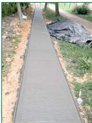
Construcción Vía Peatonal - Marengo
