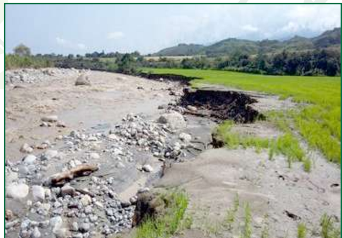
Daños derivaciones y cultivos, Río Neiva, Campoalegre, Río Frío
