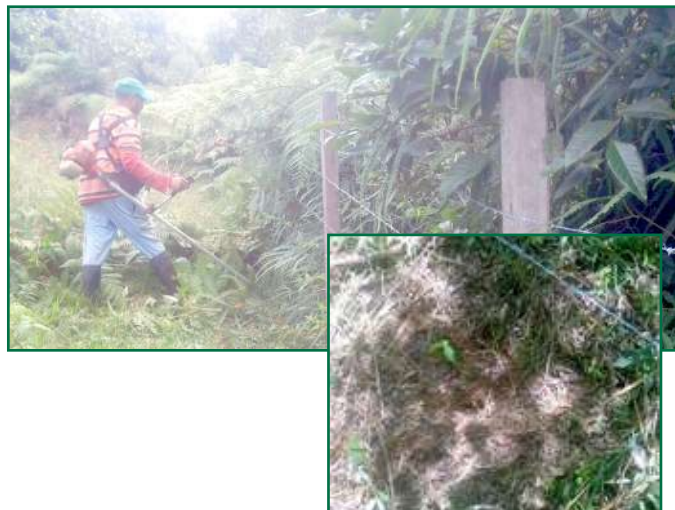
Mantenimiento aislamiento año 2, predio El Silencio, Vereda Los Planes -Campoalegre.
