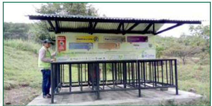
Punto limpio, Vereda Ceibas Afuera
