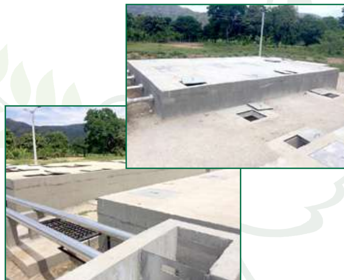
Construcción planta de tratamiento de aguas residuales domésticas del municipio de Guadalupe.
