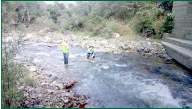
Río Las Ceibas, puente El Batán, vereda Motilón
