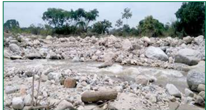
Daños derivaciones, Río Frío Rivera.
