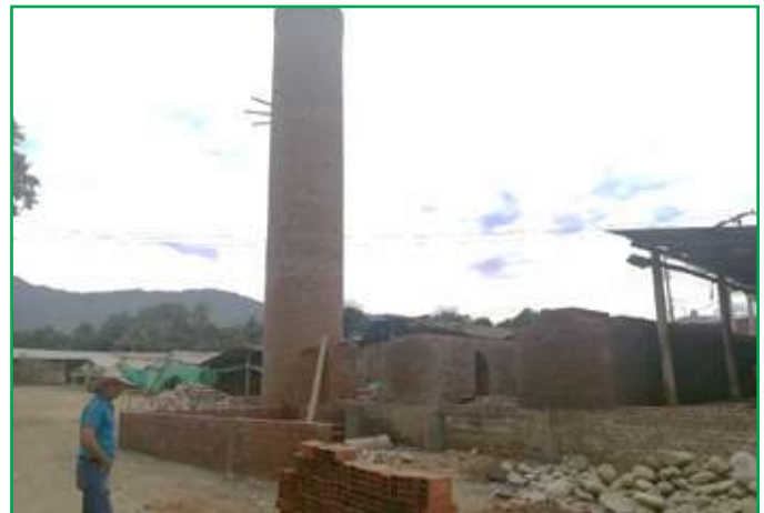
Construcción de Horno tipo Zic Zac - Campoalegre
