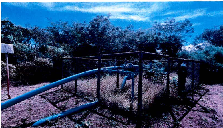
Registro fotográfico No. 3 Pozo Arenas -3, donde se evidencia que el pozo se encuentra inactivo, y no cuenta con equipo de conexión eléctrica. Fuente: Propia.
