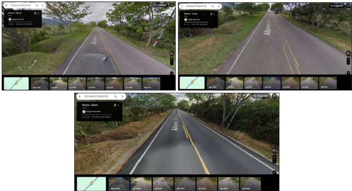
Figura No. 7 Panorámica obra hidráulica UF4-85 Vereda Llanos de la Virgen, Municipio Altamira – Huila.
