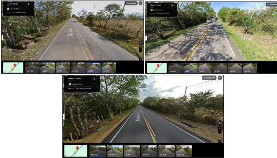
Figura No. 6 panorámica obra hidráulica UF4-84 Vereda Llanos de la Virgen, Municipio Altamira – Huila
