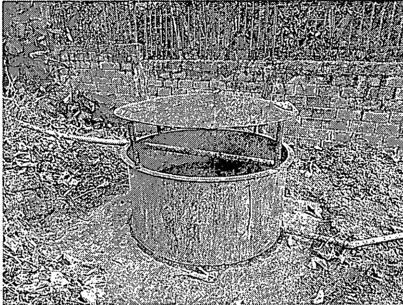
Foto 11: Evidencia fotográfica del sistema de tratamiento de aguas residuales domésticas - S<sup>T</sup>ARD, implementado en el Condominio Hacienda Mayor (Unidad Lechos de secado indicado en la visita)
