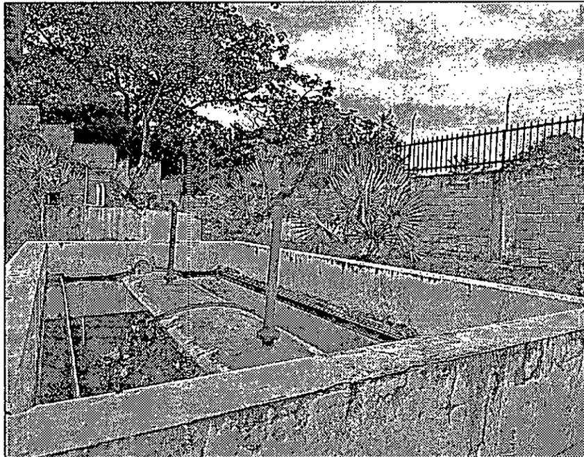
Foto 7: Evidencia fotográfica del sistema de tratamiento de aguas residuales domésticas – STARD, implementado en el Condominio Hacienda Mayor (Biodigestor anaerobio)
