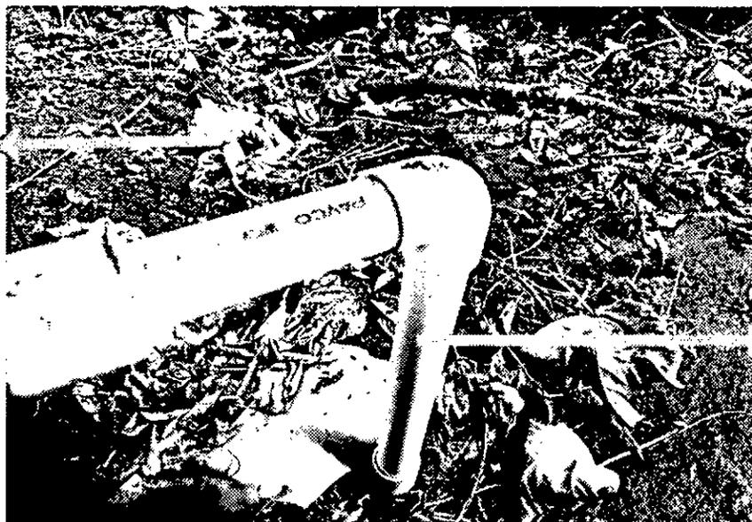
Tubería por donde se conducen las aguas residuales domésticas, provenientes de los lechos de secado
