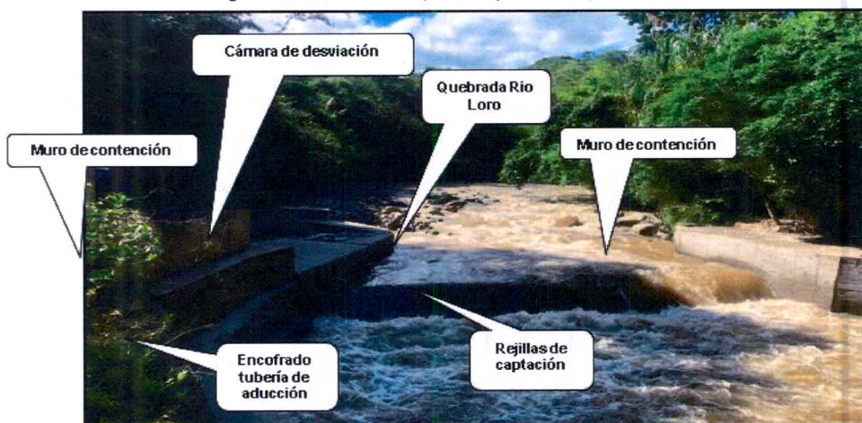
Imagen 15 – Punto de captación y sus componentes
