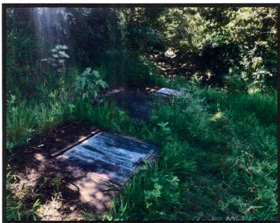
Imagen 18 - Obra hidráulica válvula de lavado y caja de limpieza
