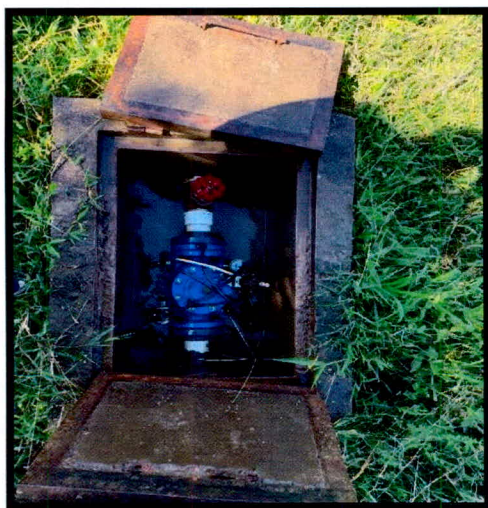
Imagen 20 – Obra Hidráulica de captación Intrapredial - Hidrante
