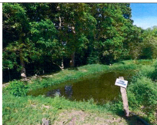
Fotografía 8. Laguna de oxidación
