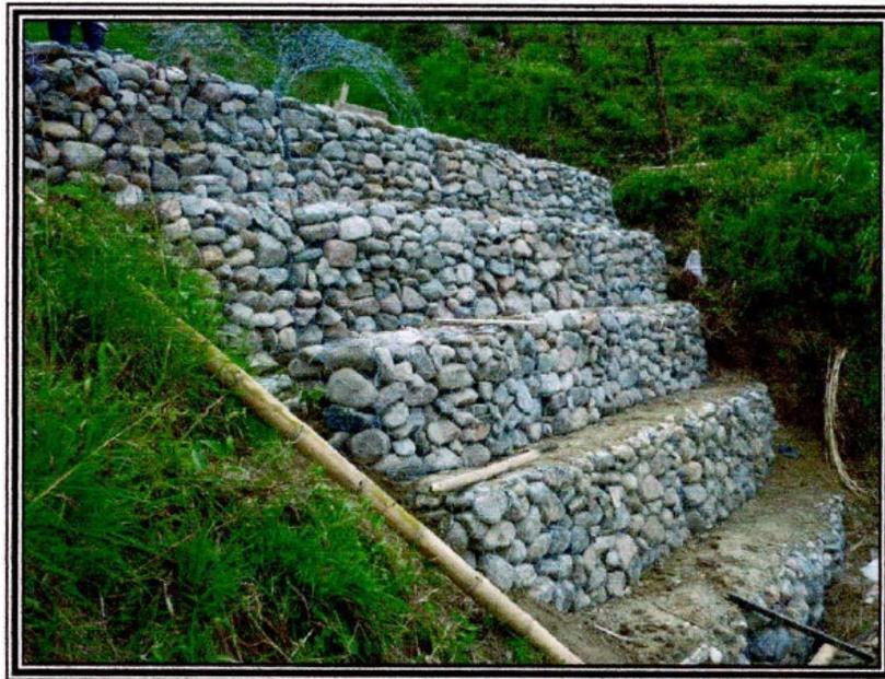
FOTOGRAFÍA 7. Gaviones contruidos para estabilización de los taludes.
