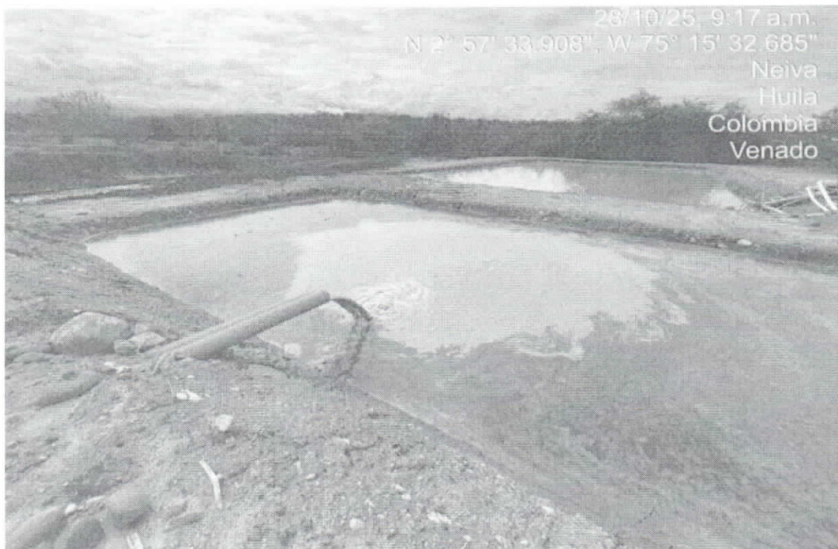
Foto No. 7: Evidencia fotográfica Panorámica de las piscinas de sedimentación.
