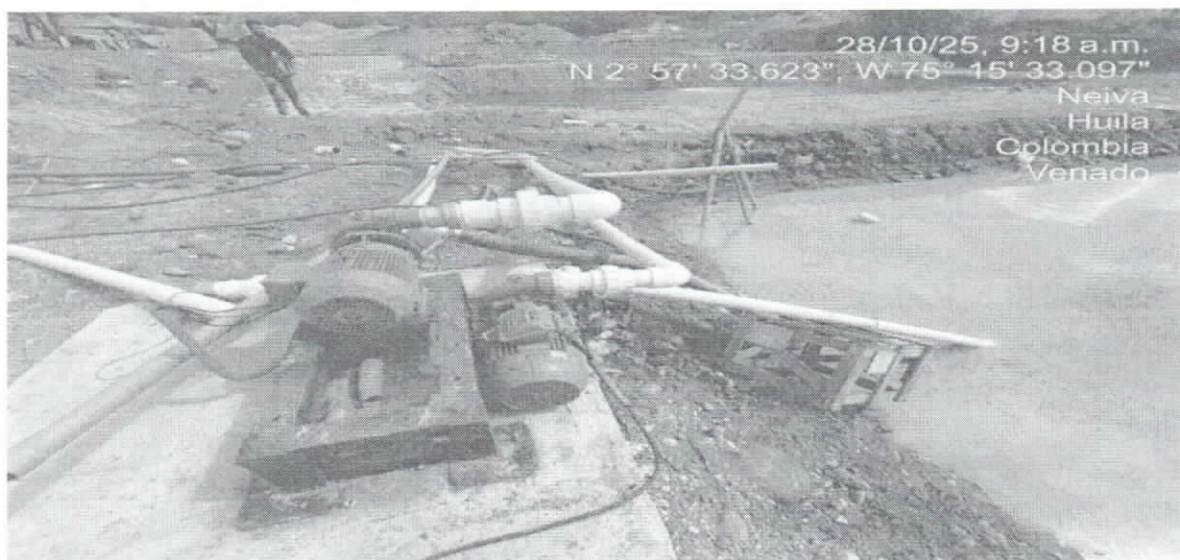
Foto No. 8: Evidencia fotográfica de los motores eléctricos por medio de la cual se realiza captación de agua.
