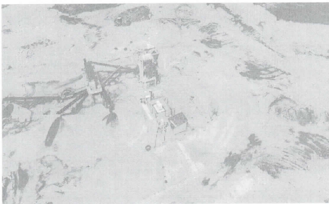
Fotos No. 1, 2 y 3: Evidencia fotográfica de la planta de trituración ubicada en el Lote San Luis - Lote 2B, kilómetro 1 vía Campo Tello, vereda Sector Venadito.
