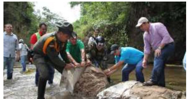
Desmante de diques en bolsas de arena para coste mantener el río en la finca las Nieves.
