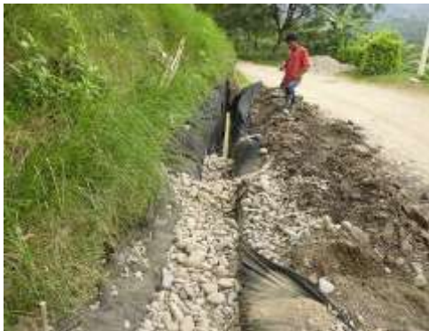
Construcción filtro francés, vereda Los Cauchos
