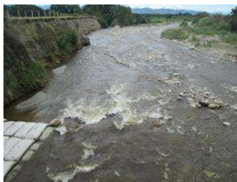
Puente Argelino Duran, corriente Neiva, Municipio Campoalegre
