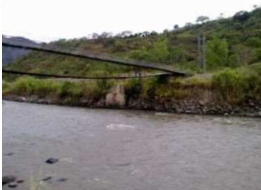
Estación Puente Ricaurte, corriente Páez.
