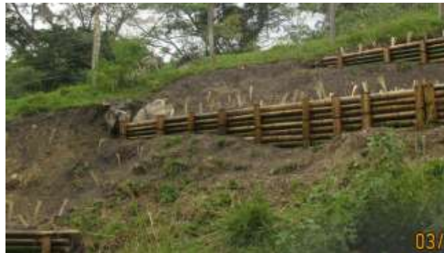
Reconstrucción de trinchos en Floragaita
