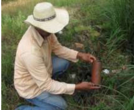
Limpieza de filtros de anillos
