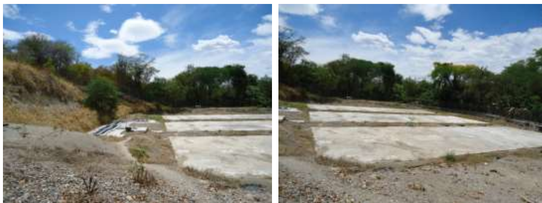
PTAR del municipio de Aipe
