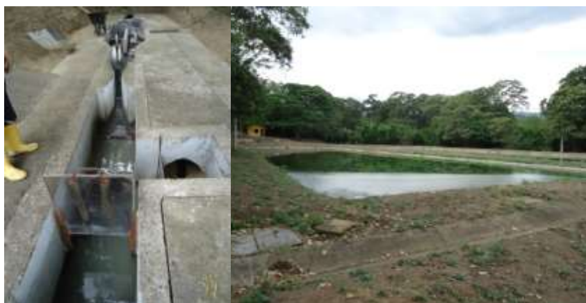
PTAR del municipio de Baraya
