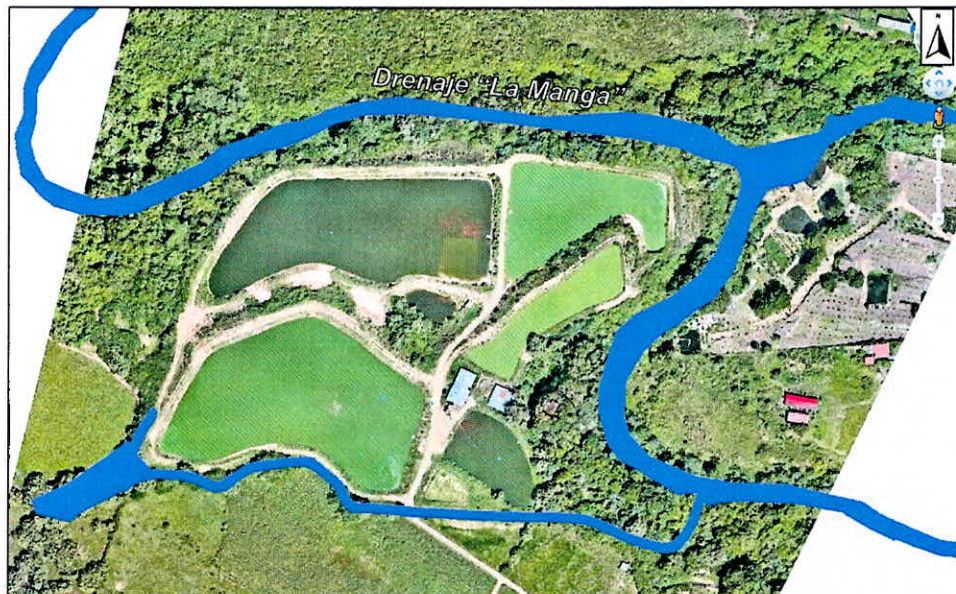
Imagen No.5. Drenaje “La Manga”, vereda Albadan, Rivera (Huila). Fuente: Acotamiento drenaje “La Manga”.
