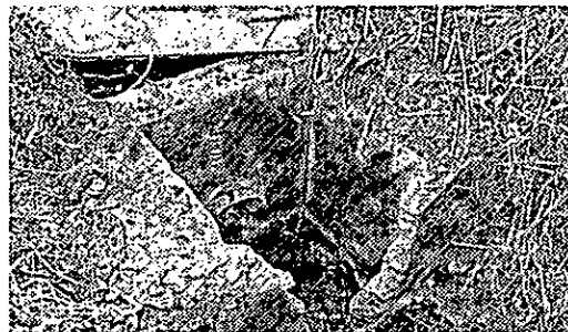
Fotografía 4 - 5. Salida del agua residual sobre zanja no revestida.
