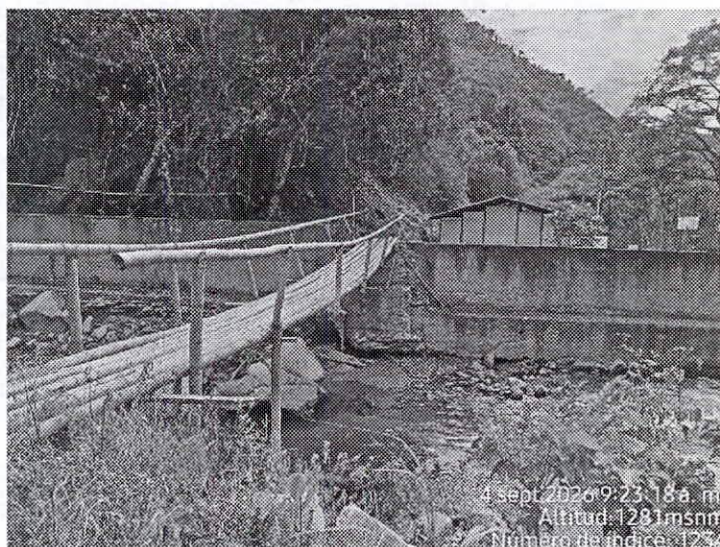
Registro Fotográfico No 1. lugar donde se construirá el puente peatonal sobre el Río San Francisco, ubicado en las coordenadas planas de origen Bogotá 825038E 793069N.
