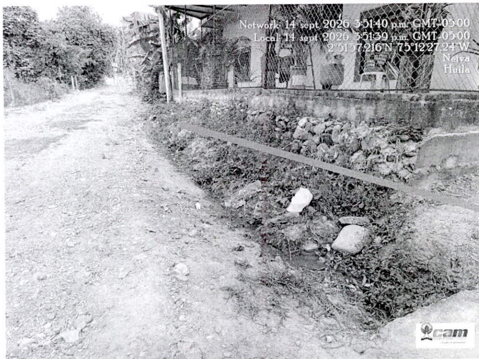
Foto 13: Evidencia fotográfica del canal en tierra por donde se conducen las aguas residuales domésticas – ARD provenientes de la casa No. 5 de propiedad de la señora María Jimena Quizá Romero y del señor Eugenio Cardozo Delgado (lavadora y la cocina)
