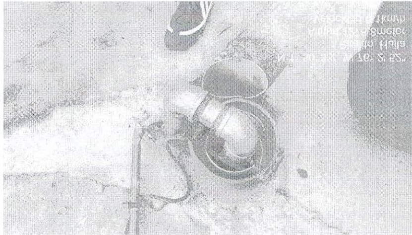
Registro fotográfico No. 3. Pozo objeto a concesionar, ubicado en la Diagonal 3 Sur No. 1ª – 33 del municipio de Pitalito (Huila). Fuente: Funcionario CAM.
