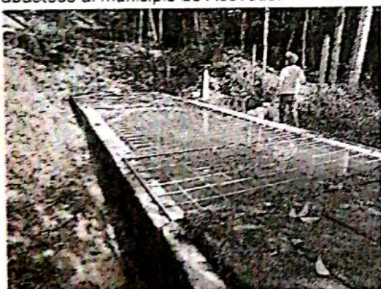
Fotografía 3. Tanque desarenador.
