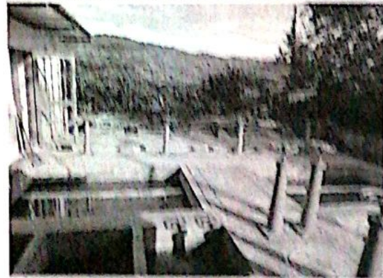
Fotografía 14. Planta de tratamiento de agua potable.
