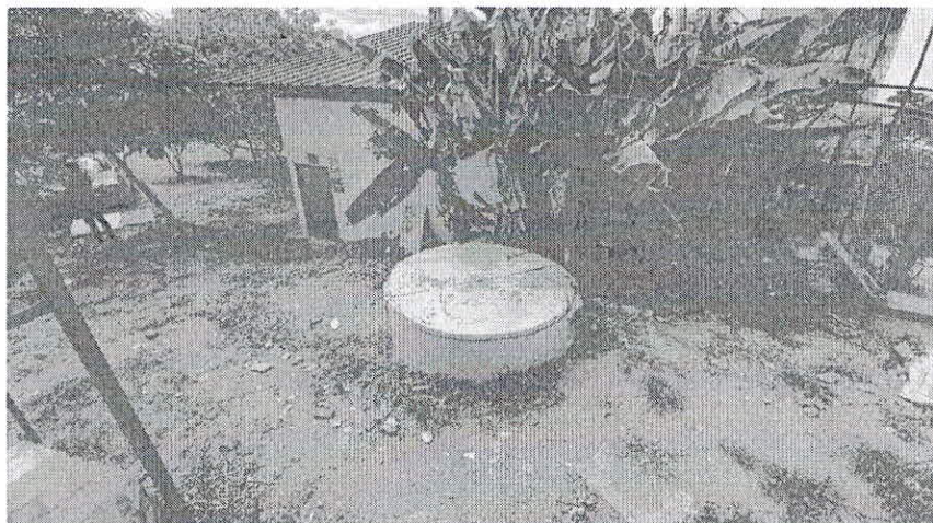
fotográficos 1: vista del aljibe para captación de agua subterránea
