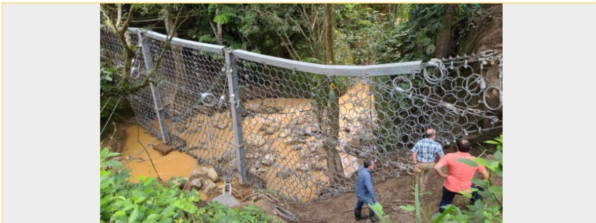
Barrera dinámica retención de detritos sobre el cauce de la quebrada Los Micos
