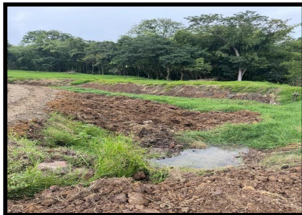
Imagen 25 – Laguna de oxidación en adecuación y mantenimiento
