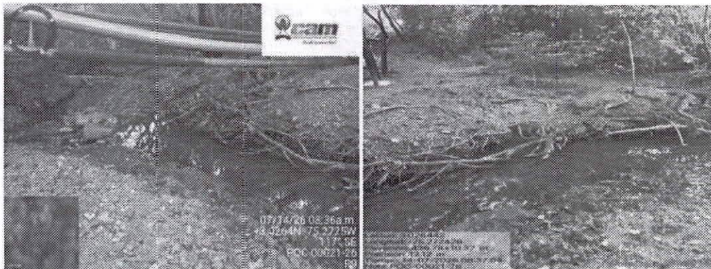
Foto 3 y 4. Punto donde se va a intervenir para las líneas de flujo.
