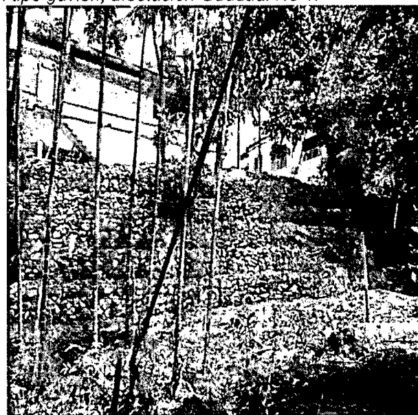
Fotografía No. 12 y 13: Muro de contención tipo gavión, afectación Guadual No 1.
