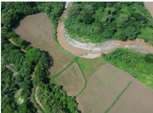
Asistencia técnica Municipio Aipe, predio Fedearroz, Quebrada Muchubí por Socavación.
