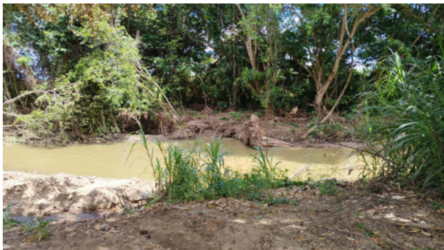
Asistencia técnica Municipio de Campoalegre, vereda Llano sur por inundación y Socavación
