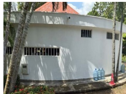
Tratamiento de humedades y pintura
