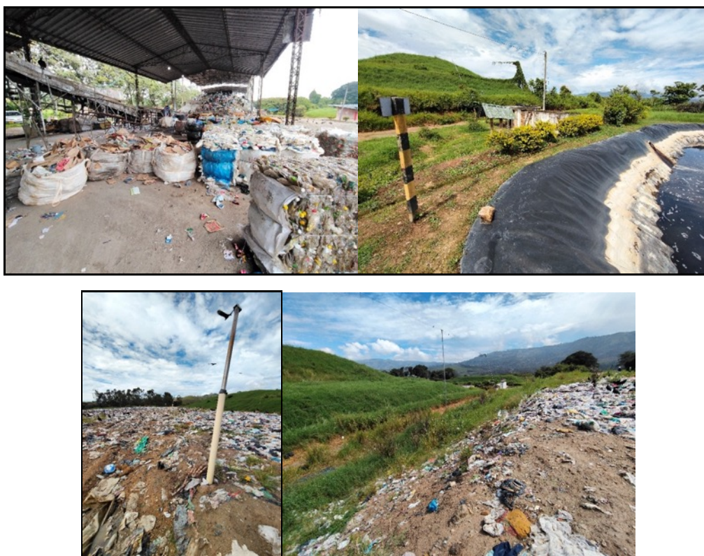
Procesos de recepción, clasificación y recuperación, Planta de Tratamiento de Lixiviados para recirculación, disposición final en celda de operación, y proceso de revegetalización en celdas clausuradas.
