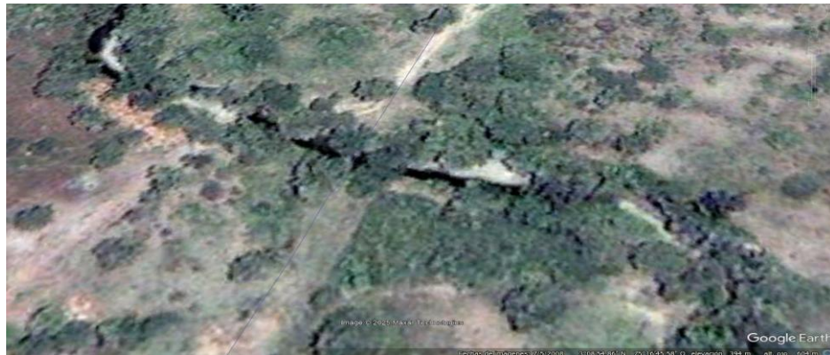
Figura 8. Ubicación Quebrada Dindal a la altura del PK 310+536 Salgar – Neiva- Sin construcción de obras.
