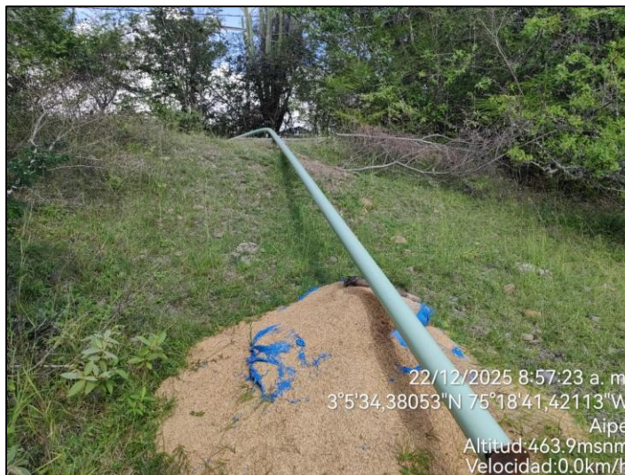
Foto 4. Nueva línea de flujo ubicada en cercanía a la ocupación de cauce sobre la fuente hídrica Quebrada Dindal.
