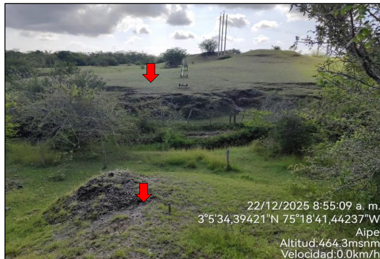
Foto 3. Puntos para la instalación, operación y mantenimiento de línea de flujo.
