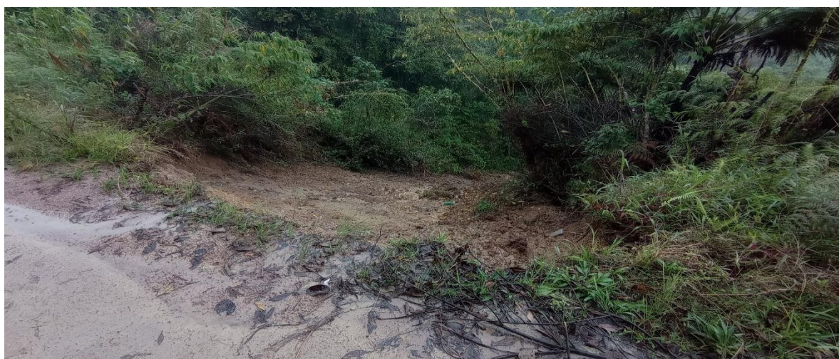
Municipio de Acevedo, deslizamiento observado en el predio La Soledad, visita de restitución de tierras
