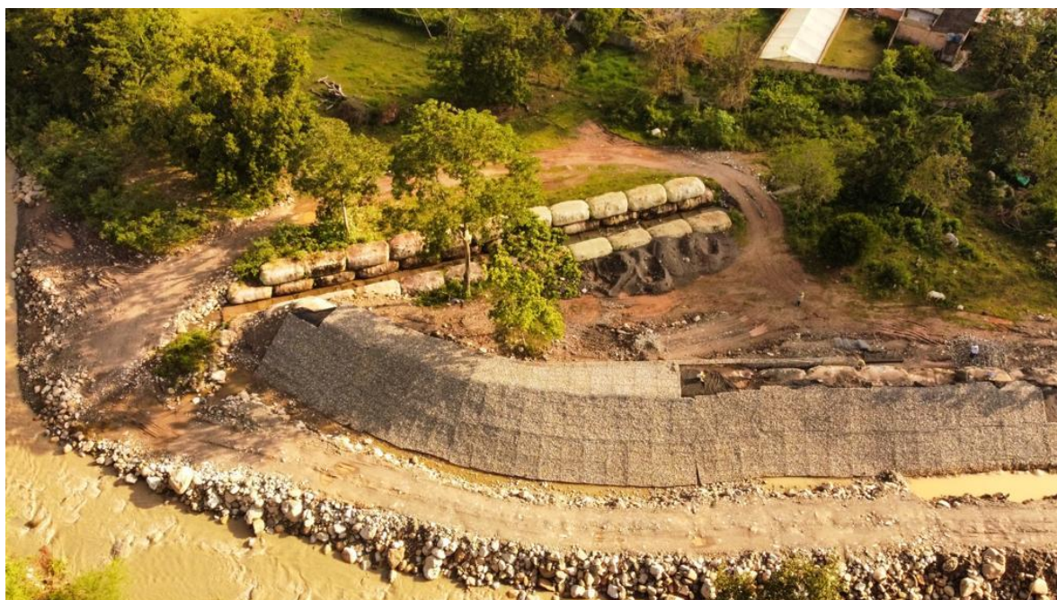
Municipio de Timaná, obra de canalización del río Timaná
