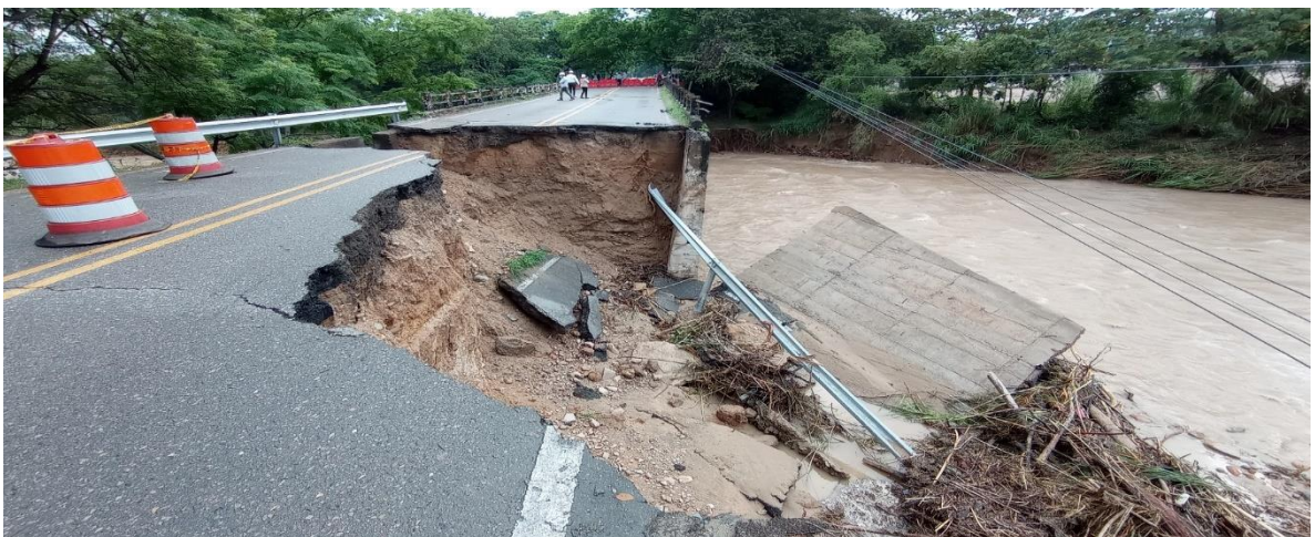
Municipio de Rivera, pérdida de parte del puente que atraviesa la quebrada Arenoso, producto de socavación lateral y de fondo
