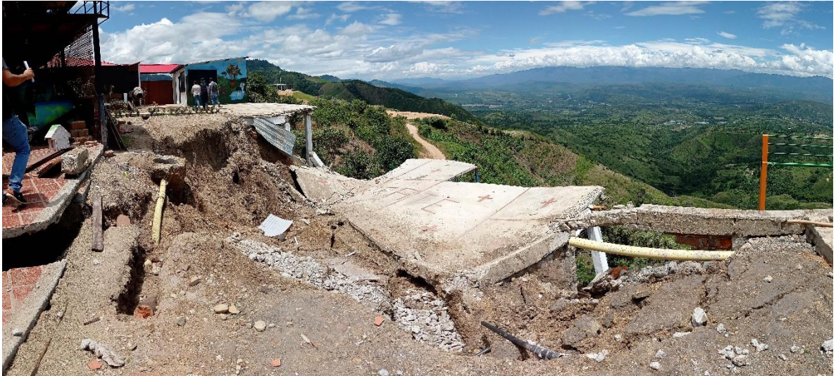
Municipio de Garzón, movimiento en masa y destrucción de un mirador en la vereda Monserrate
