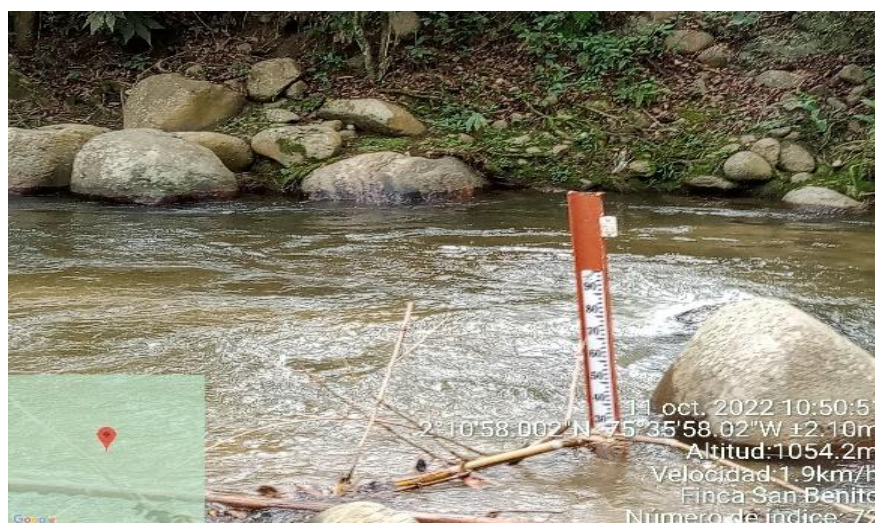
Instalación de regletas en estación finca San Benito, quebrada Garzón– municipio de Garzón
