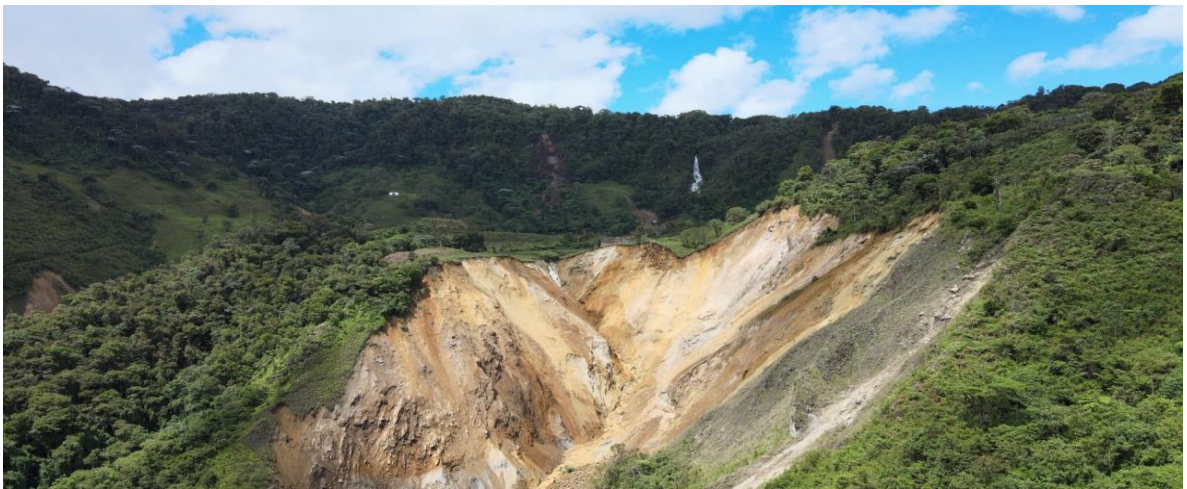
Municipio de La Plata, deslizamientos y avenidas torrenciales presentadas en el nacimiento de la quebrada La Topa
