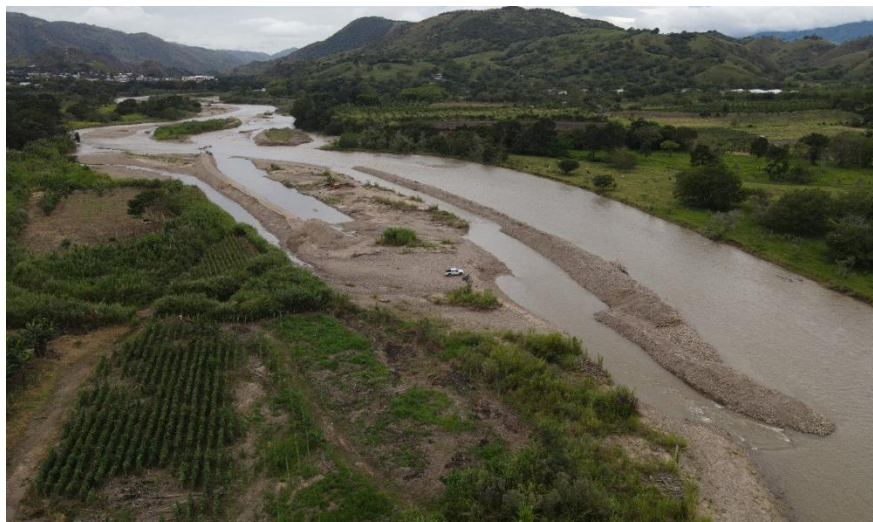
Municipio de Suaza, obras de dragado sobre el río Suaza - sector Planta de Beneficio
