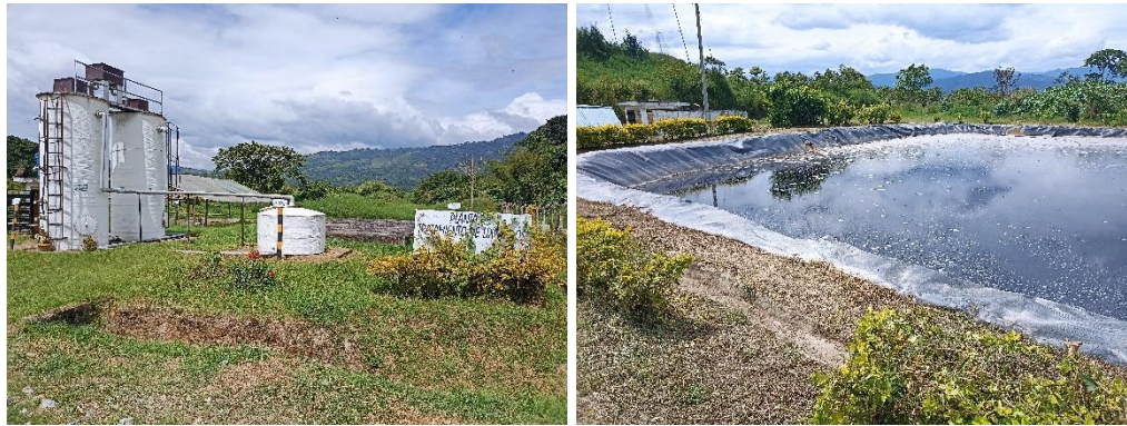
Biorgánicos del Sur – Sistema de tratamiento de lixiviados
