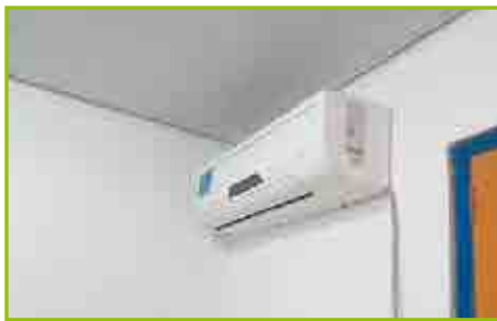
Instalación de Nuevos Aires Acondicionados para las Oficinas
