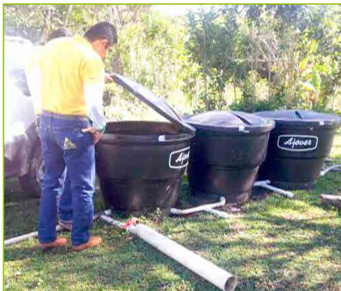
Reactor Hidrolítico Metanogénico SMTA 400 –municipio del Pital
