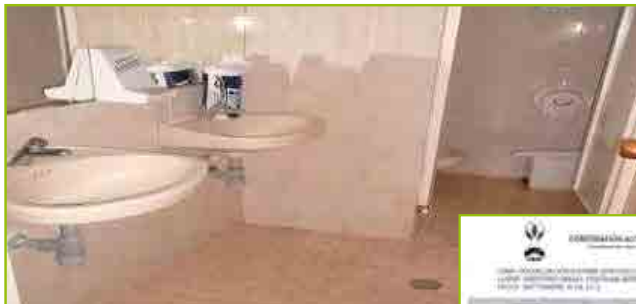
Remodelación de Baterías Sanitarias Ahorradoras
