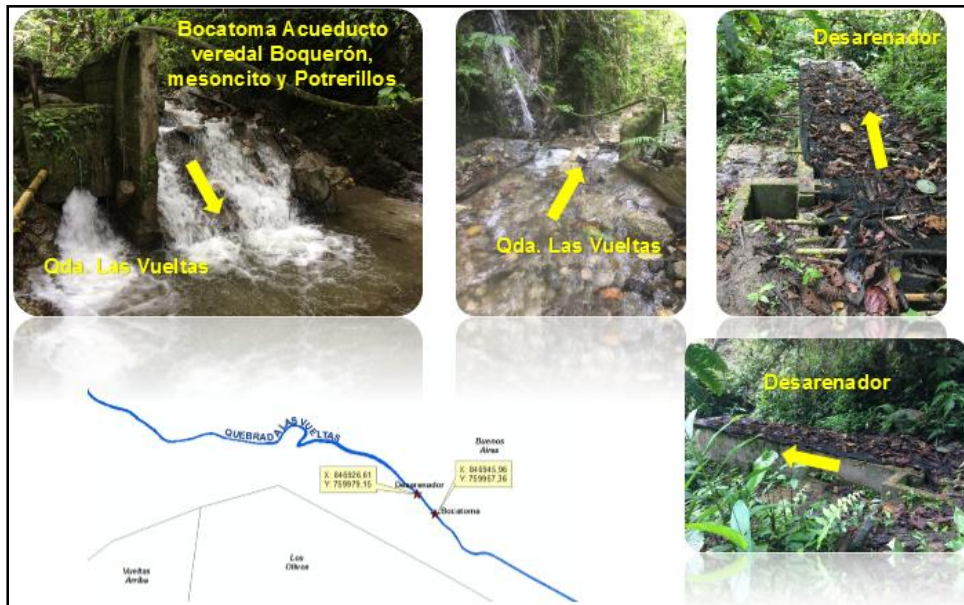
Figura 10. Acueducto veredal Boquerón, mesoncito y Potrerillos. Fuente: CONSORCIO PORH CAM, 2017.
