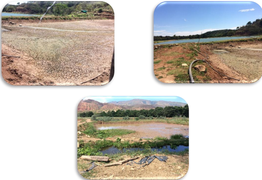
Figura 42. Construcción de lagos sobre la subcuenca de la quebrada Las Vueltas. Fuente: CONSORCIO PORH CAM, 2017.
