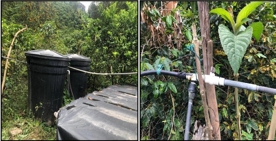
**Fotografías 4,5:** tanques de almacenamiento y distribución
