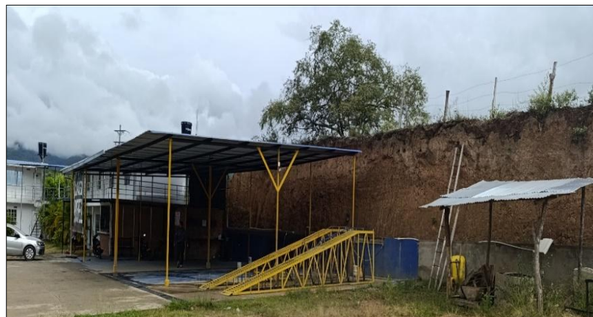
Imagen 3 – Infraestructura del Lavadero de Vehículos de la estación de servicio
