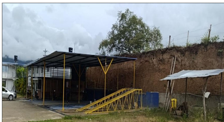
Imagen 10 – Infraestructura del Lavadero de Vehículos de la estación de servicio
