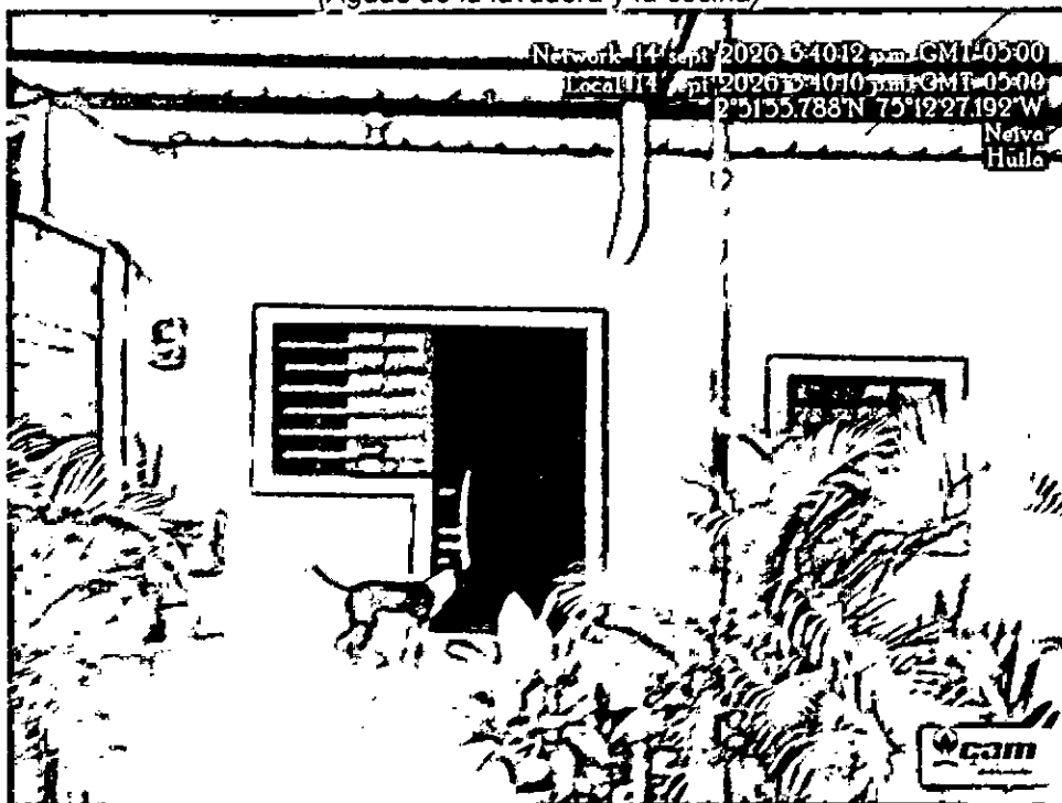
Foto 11: Evidencia fotográfica de los apartamentos que se tienen contruidos sobre el predio de la
