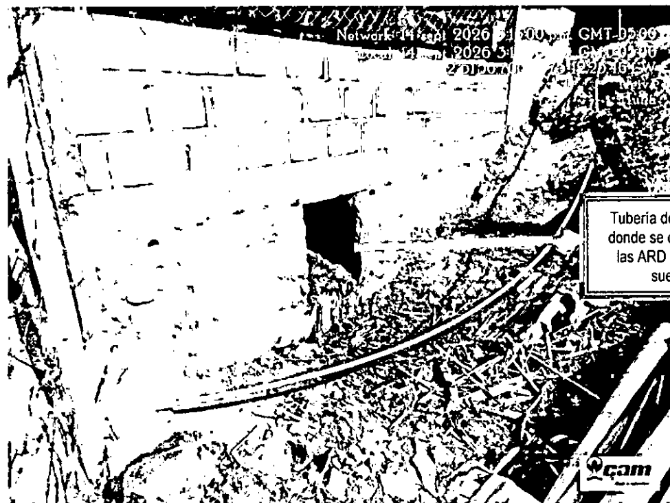
Fotos 4 y 5: Evidencia fotográfica del pozo séptico y de la tubería por donde se conducen las aguas residuales domésticas – ARD provenientes de la casa No. 1 de propiedad del señor Carmelo Hernández Tovar (Aguas de la lavadora y la cocina)
