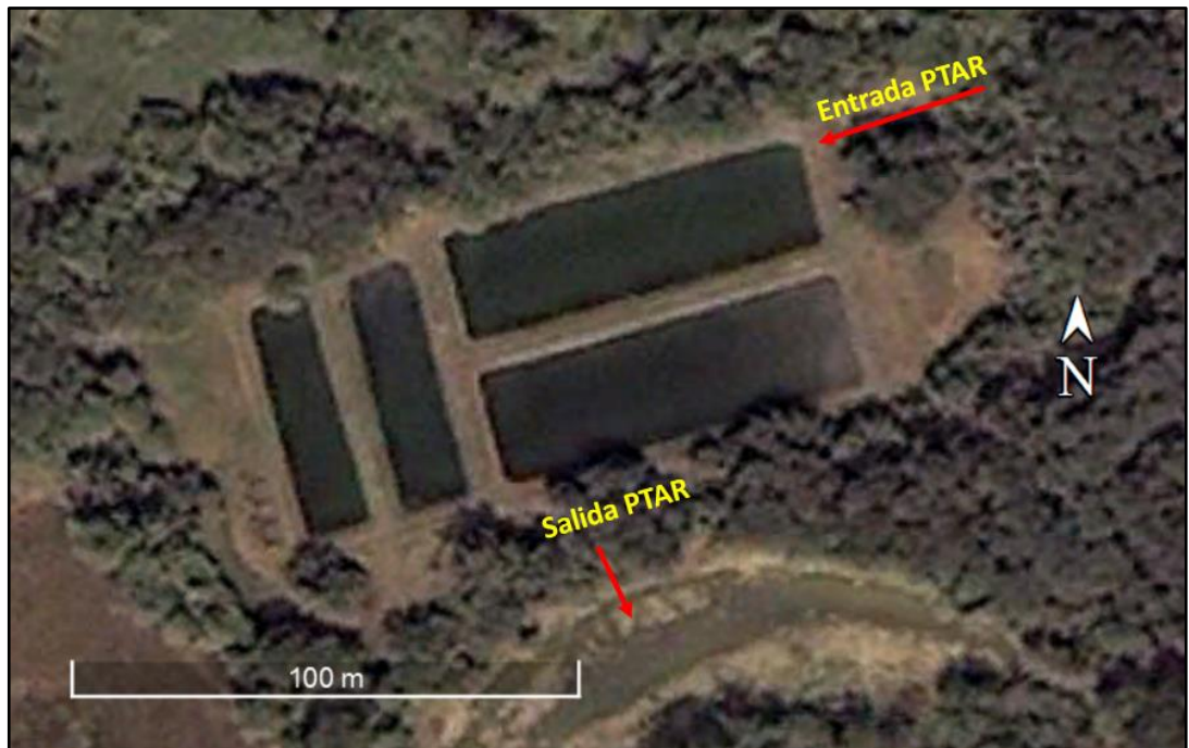
Figura 10. Lagunas de Oxidación – PTAR. Fuente: CONSORCIO PORH CAM, 2017.
