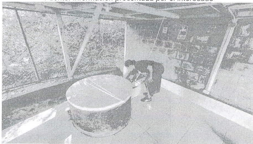
Registros fotográficos 1: vista del aljibe para captación de agua subterránea
