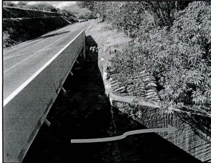
Fotografías 7, 8 y 9: Puente área de desencole del afluyente zanjón los Loros, afluyente a su vez de la quebrada Laberintos, que desemboca al río Magdalena en la margen derecha - ruta - 45-05 - vereda El Espinal – Gigante - Huila
